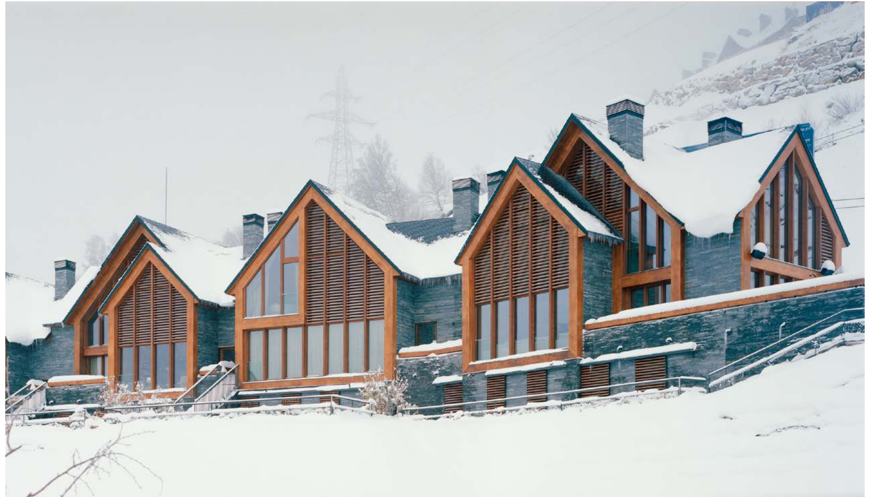
38 viviendas Pleta Arriu | Mano Arquitectura
